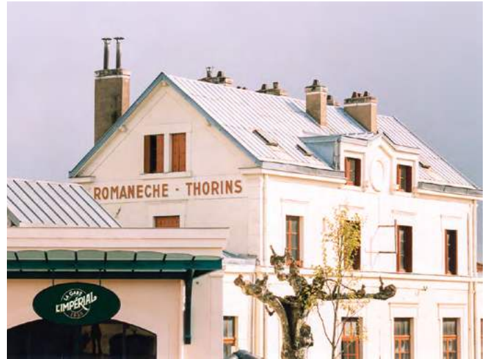
La Gare entièrement restaurée
